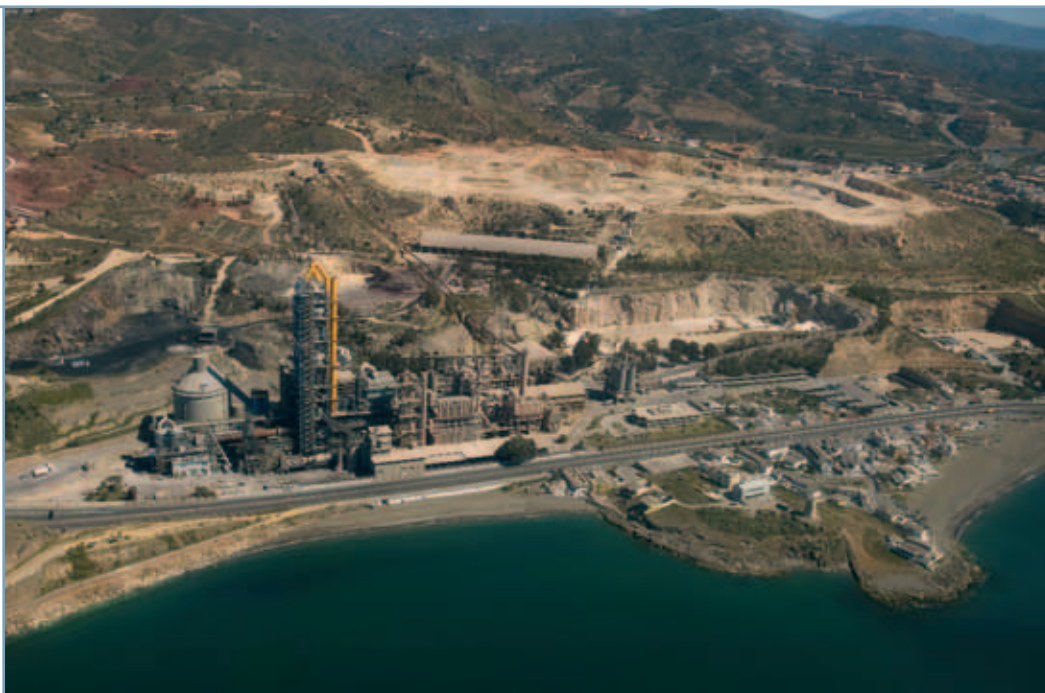
La cementera Goliat contamina la playa de La Araña en Rincón de la Victoria (Málaga)
