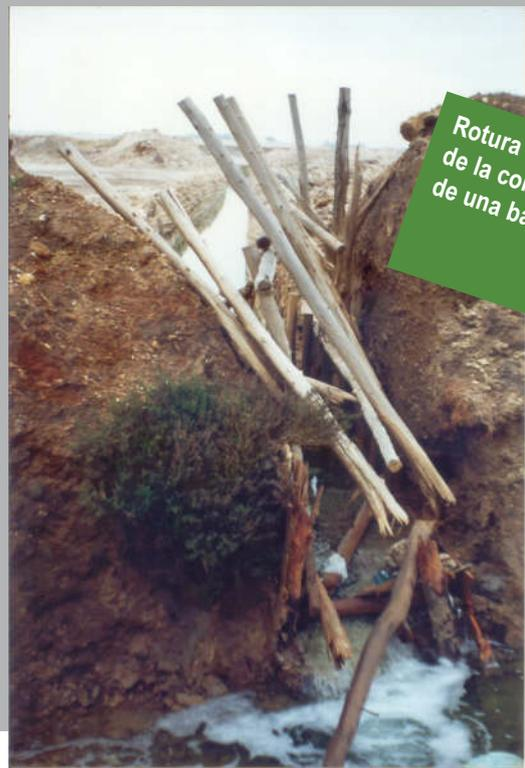
Rotura perimetral de la contención de una balsa
