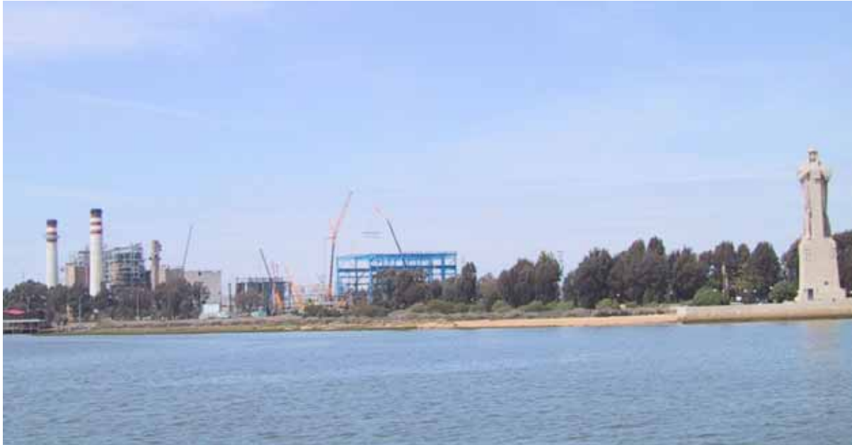
2005-04-20 - Detalle de obras de la Nueva Central sin Licencia, construyéndose gracias a una medida cautelar del TSJA. de Sevilla. El Plan General prohíbe nuevas industrias contaminantes en Punta del Sebo.
